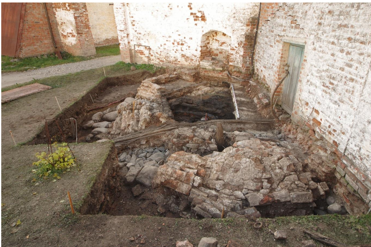
Илл. 5. Грановитая башня. Фундамент и остатки кирпичной кладки северо-восточного фасада.
