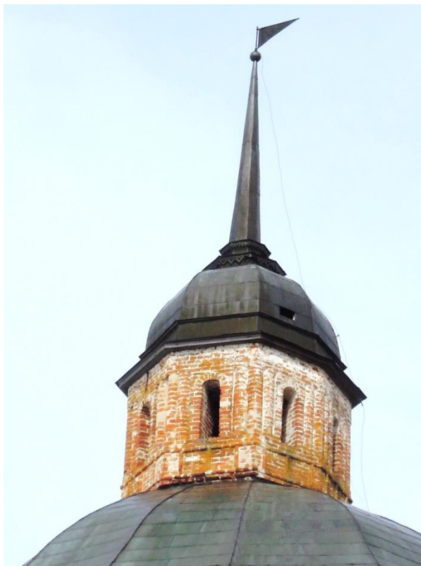
Фотография 9. «Смотровья». На поверхности стен отмечены локальные очаги биопоражений, деструкция кирпичных поясков.
