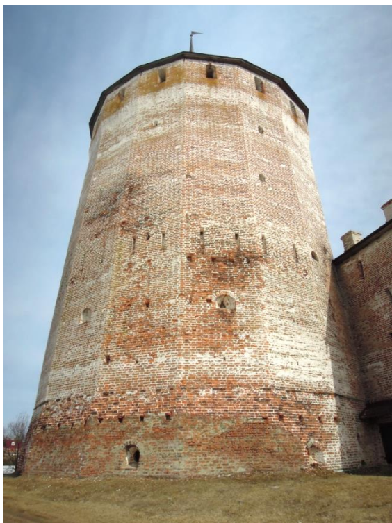
Фотография 4. Северо-западный фасад башни. На поверхности стен отмечены локальные очаги биопоражений.
