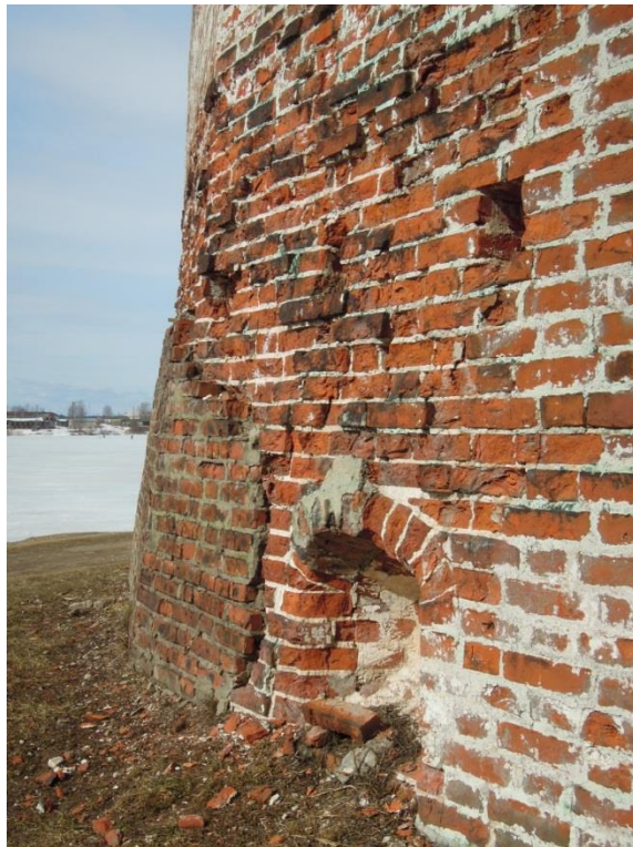
Фотография 3. Деструкция кирпичной кладки. На плоскостях стен отмечены деформационные трещины вертикальной направленности, шириной раскрытия до 15 мм.
