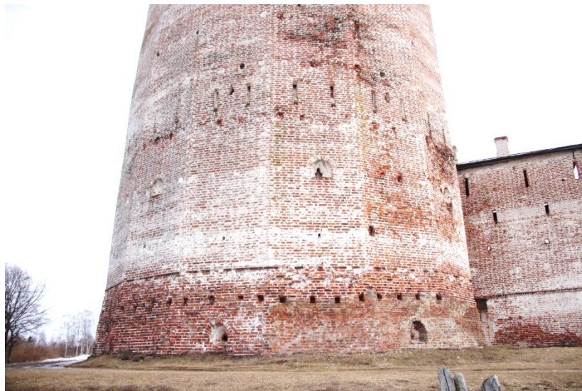
Фотография 5. Деструктурированный участок
