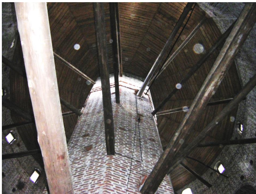
Фотография 10. Яруса башни образованы балками-спицами, опирающимися на наружную стену и центральный столп.
