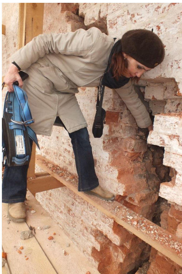
Фотография 3. Трещина на западном фасаде
