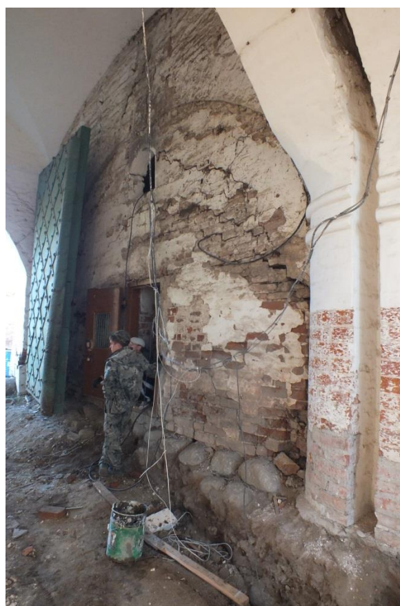
Фотография 4. Состояние перегородки до реставрации
