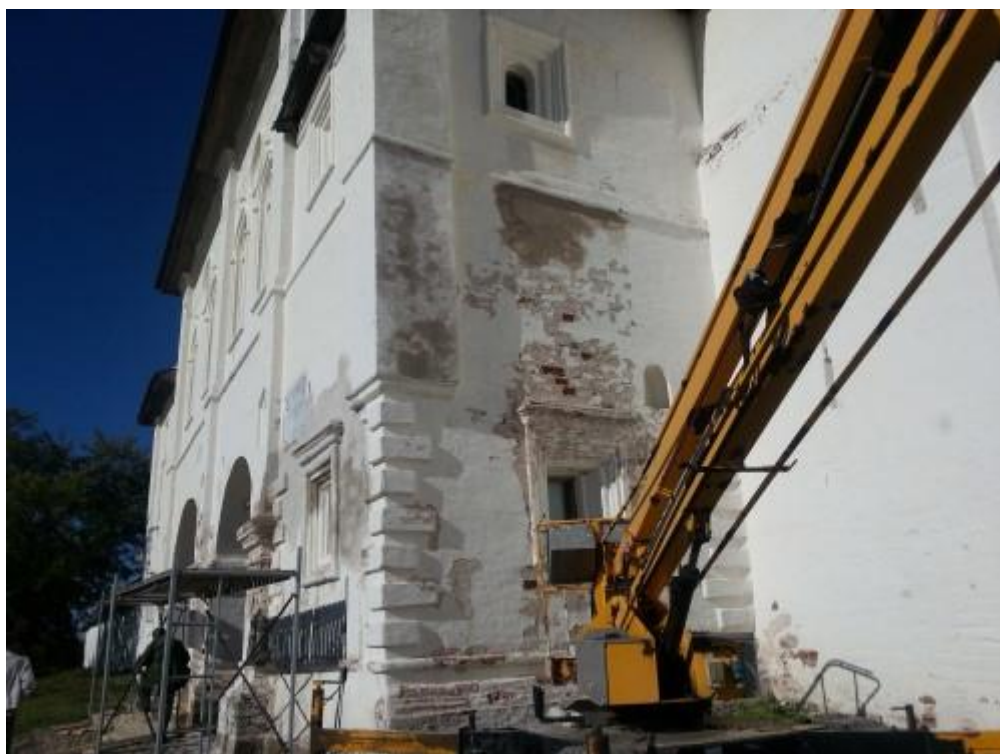
Обмазка и покраска.
