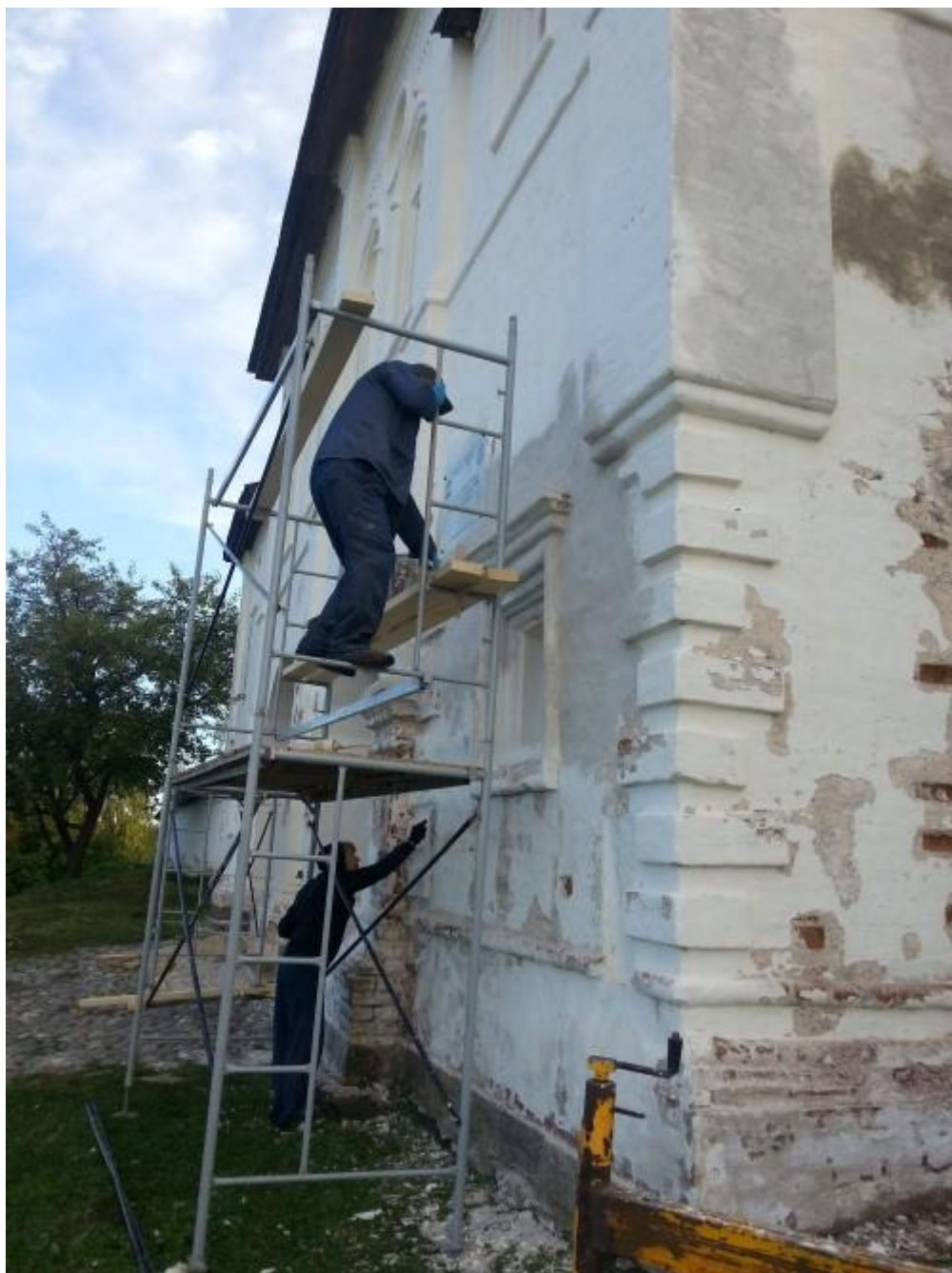
Расчистка стен, обмазка.
