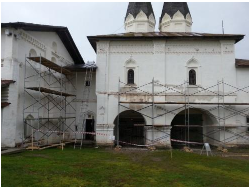
Работы с лесов.
