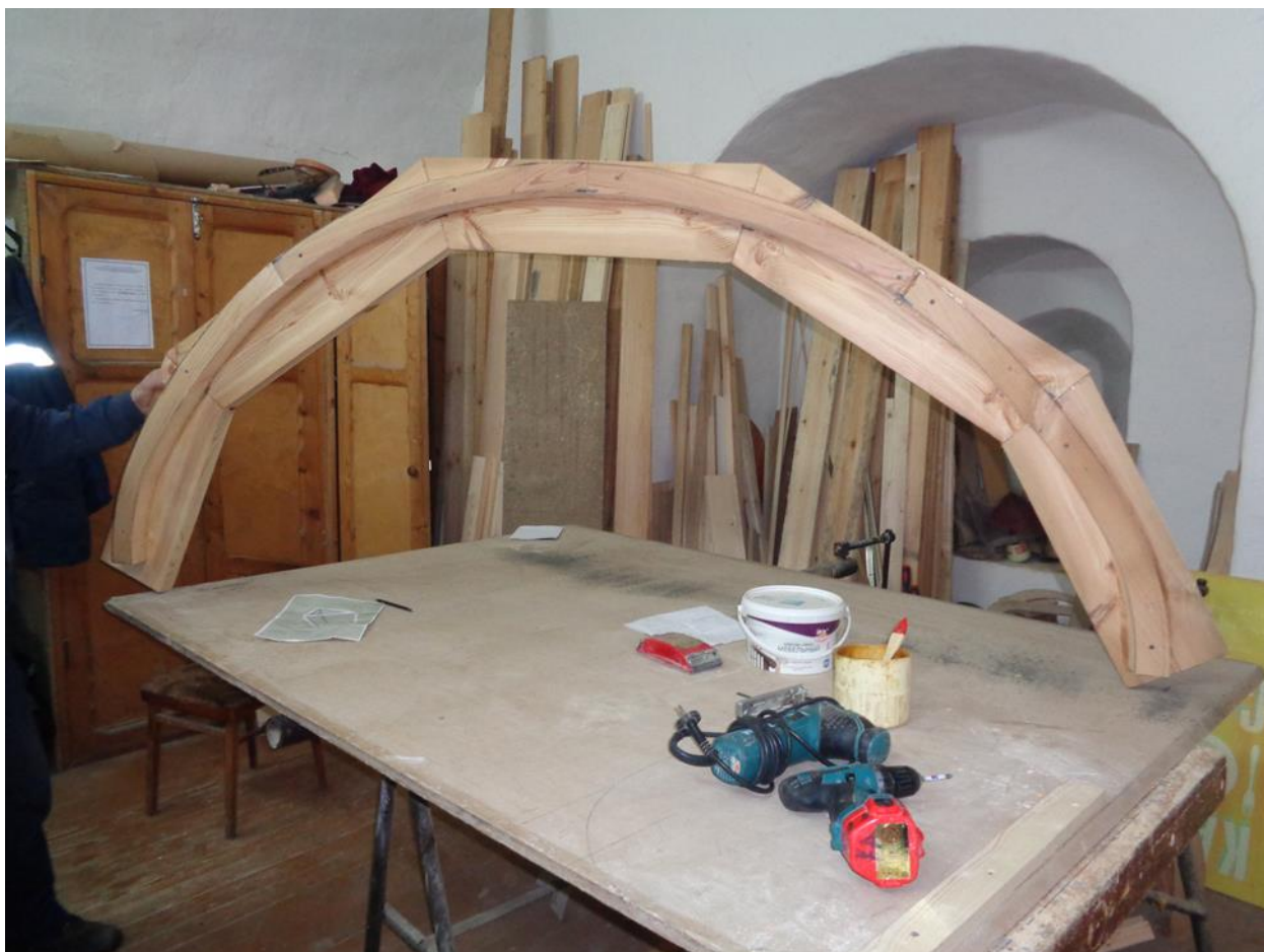
Фото 1. Изготовление рамы для слухового окна Архимандричьих келий
