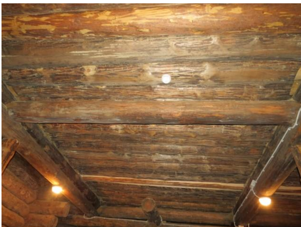
6. Балки наката подклета восьмерика после обработки
