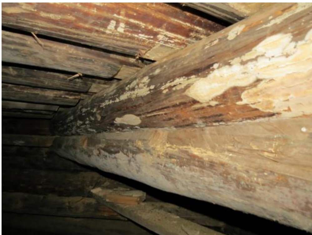
3. Опорные балки перекрытий подклета до обработки
