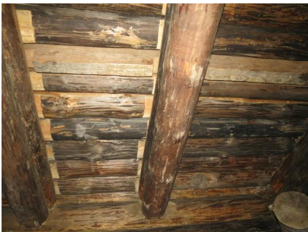
9. Опорные балки и балки наката перекрытия подклета алтаря после обработки
