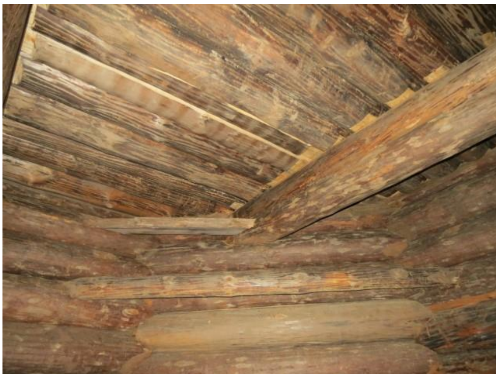
10. Угловые соединения и верхние венцы бревен подклета алтаря после обработки
