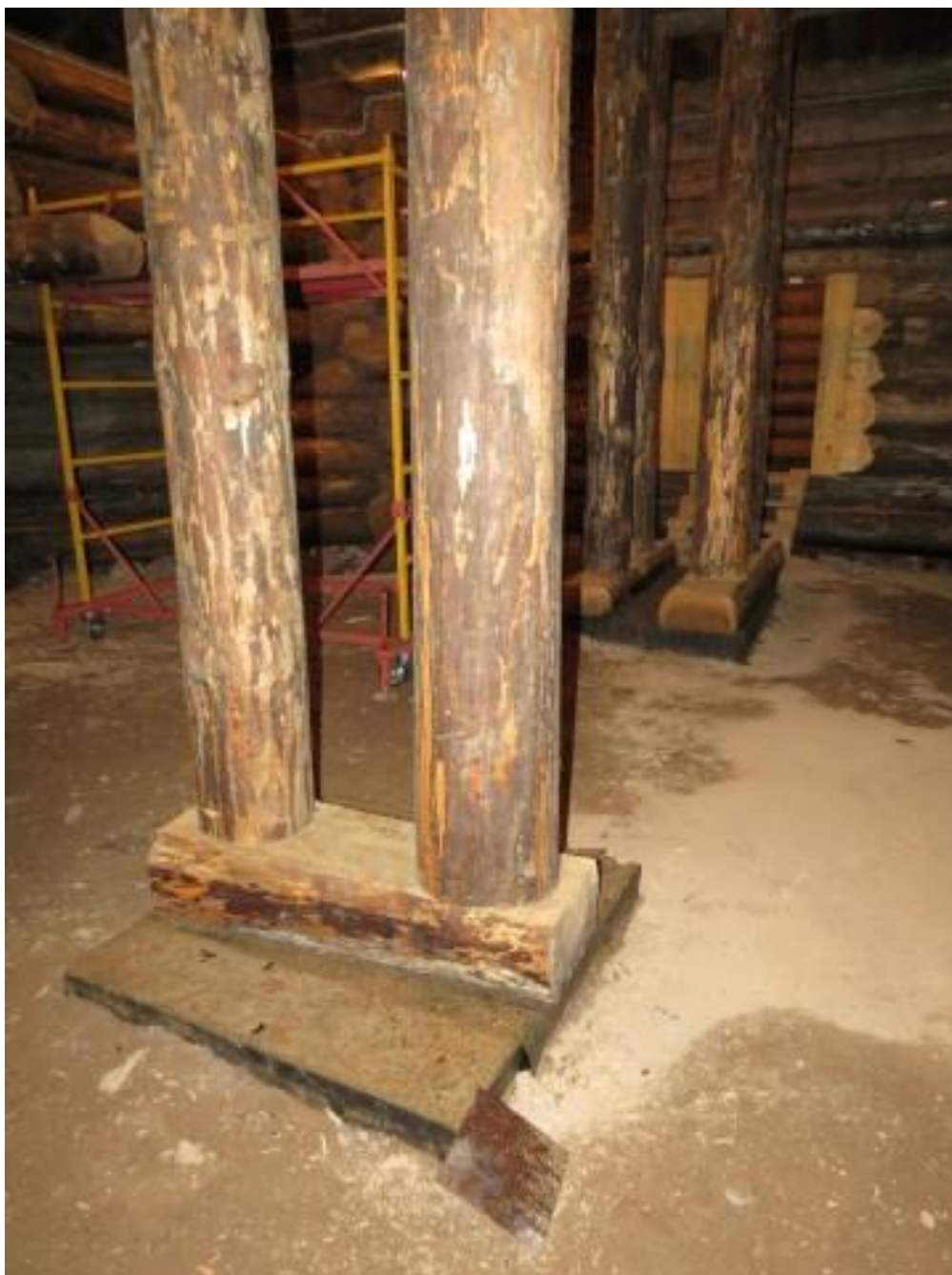
7. Опорные стойки и плахи-подушки под ними после обработки
