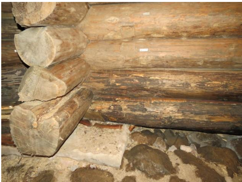
5. Нижние венцы бревен сруба восьмерика после обработки
