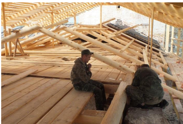
Фотография 11. Слеговая конструкция кровли
