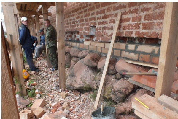
Фотография 9. Реставрация контрфорса на городском фасаде
