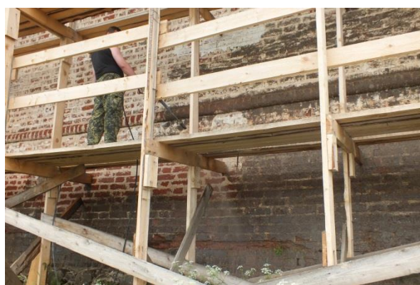
Фотография 10. Процесс расчистки фасада
