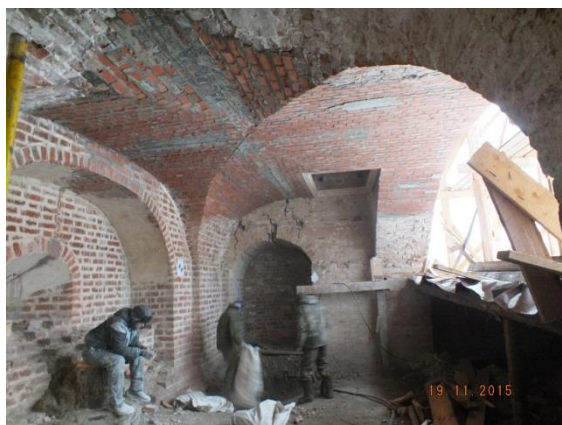
Фотографии 7, 8. Восстановленные своды второго яруса Тюремного двора после реставрации 2015 года
