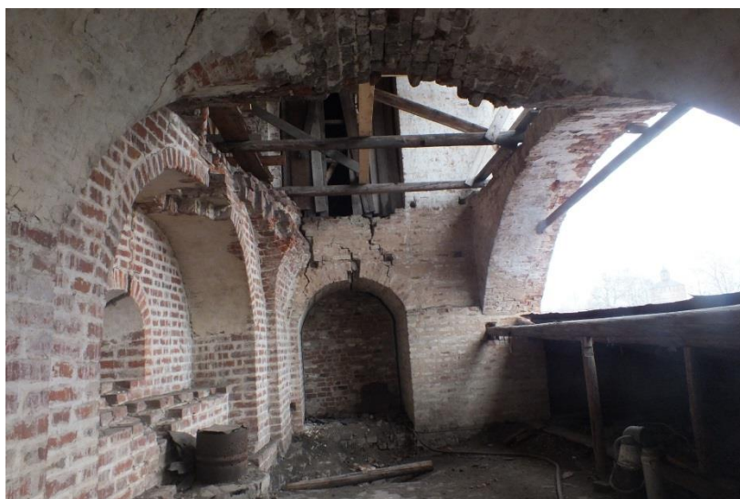
Фотографии 2, 3. Руинированные своды второго яруса Тюремного двора до реставрации 2015 года
