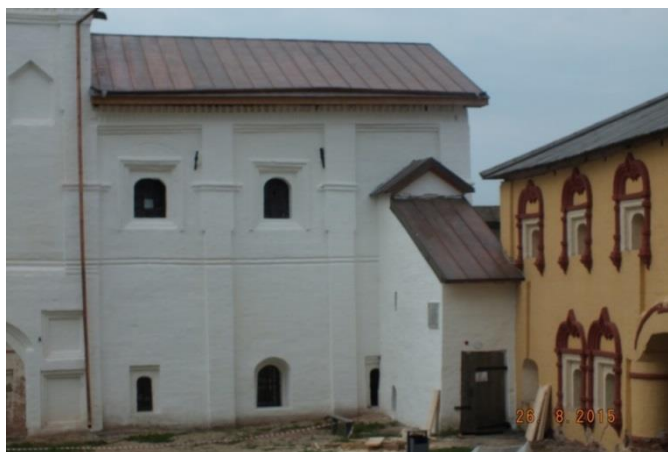
Фотография 6. Покрытие медной кровли над трапезной палатой
