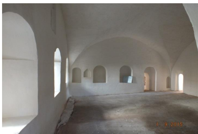
Фотография 3. Восстановление защитной обмазки и побелки интерьеров
