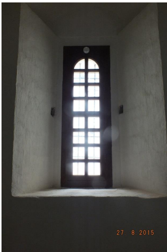
Фотография 8. Замена оконных столярных заполнений (на деревянные со стеклопакетами)
