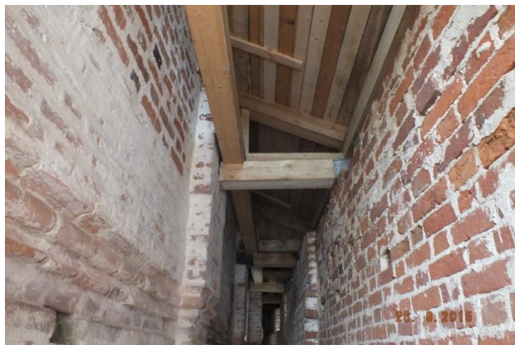
Фотография 10. Кровля над крепостной стеной после реставрации
