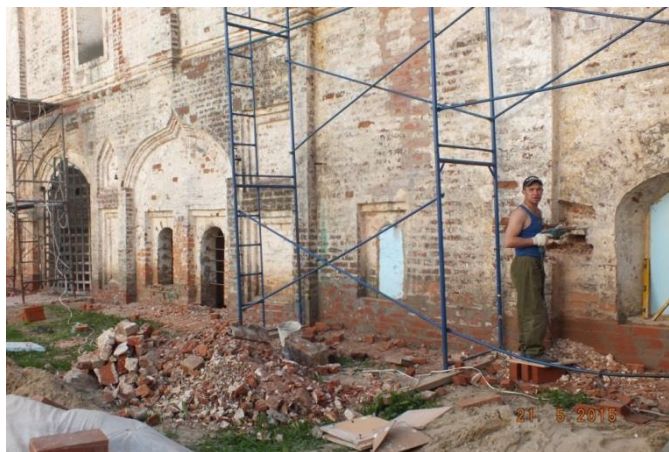
Фотография 1. Реставрация кирпичной кладки фасадов
