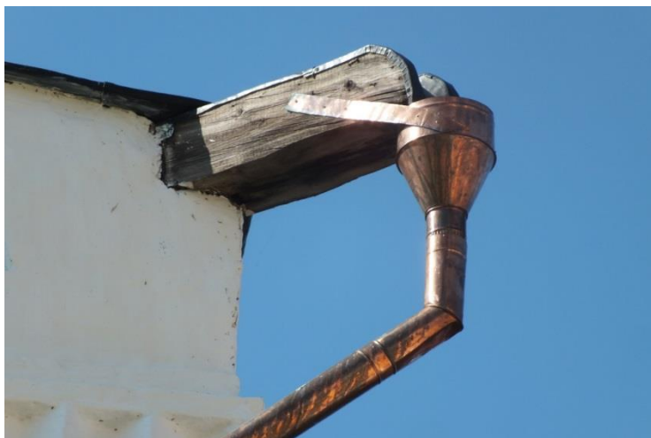
Фотография 11. Восстановление системы водосливных устройств, проведение консервационных работ на деревянных водометах
