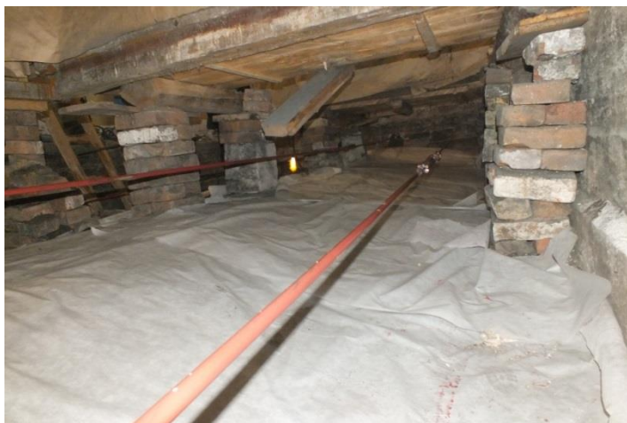
Фотография 4. Продольные стены, связанные между собой стальными поперечными связями по всей длине здания над сводами под полом второго яруса
